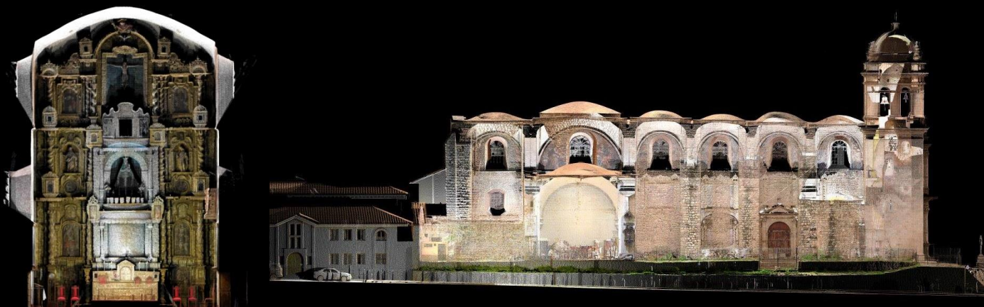
Fig1-2_Tempio di Belén: visualizzazioni 3D nel software JRC 3D Reconstructor
